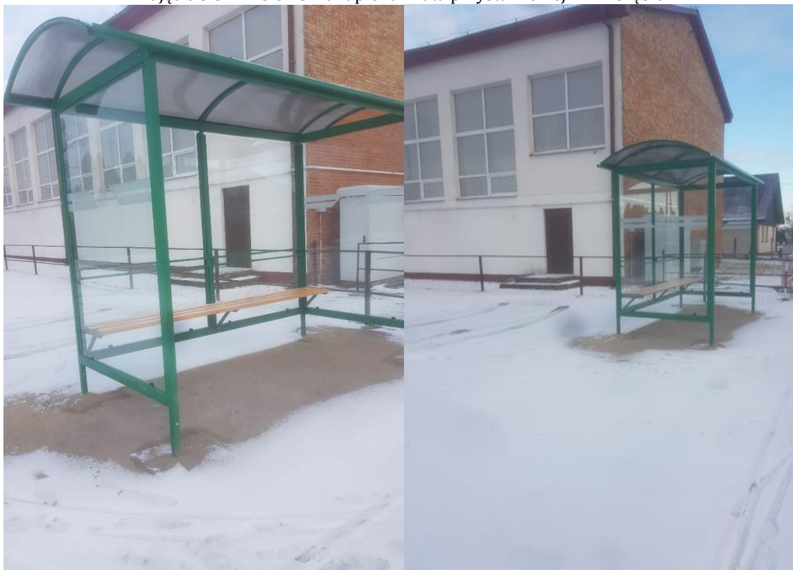
Zdjęcie 5.6.12 i 5.6.13. Zakupiona wiata przystankowej w Przerębie
