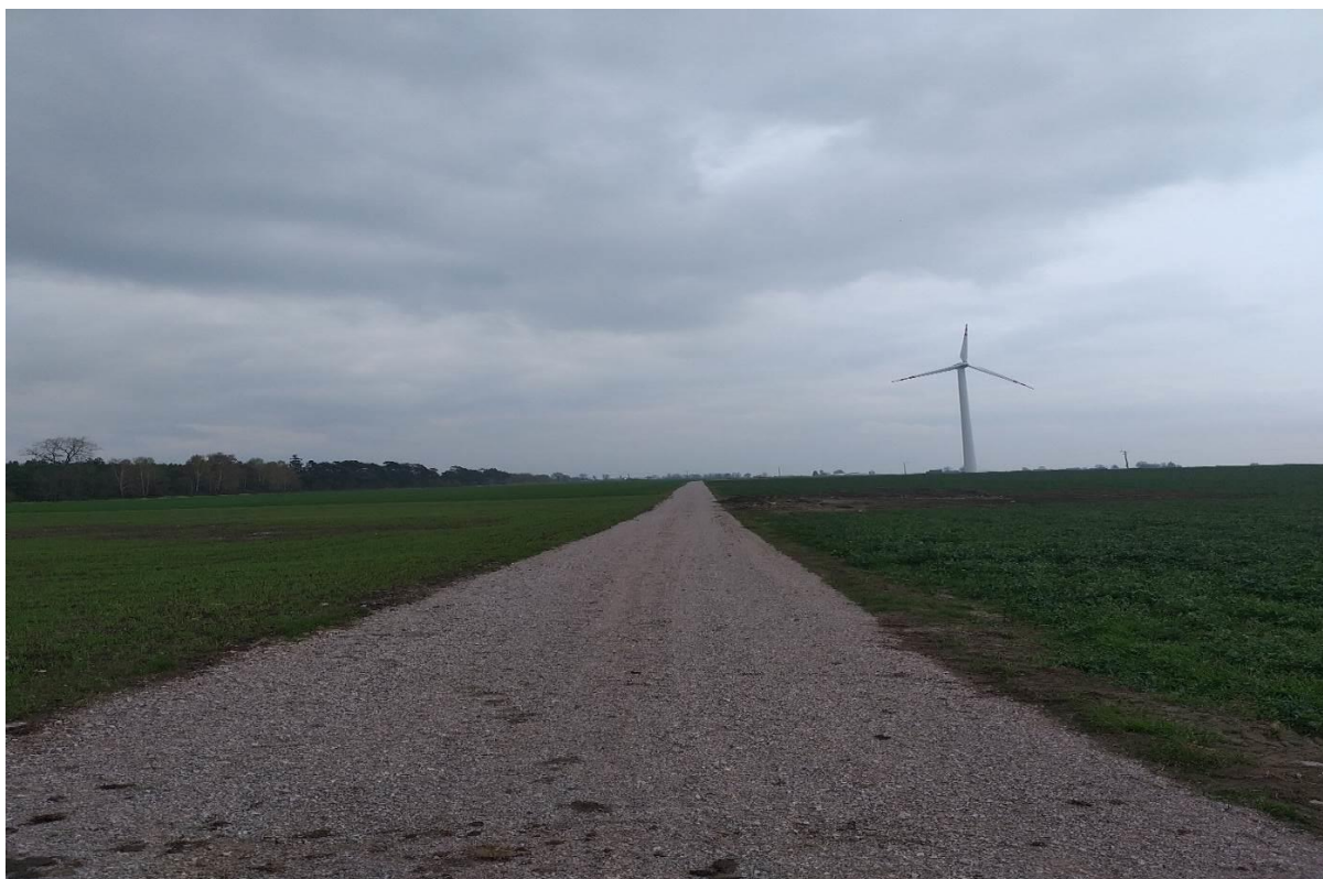
Zdjęcie 5.3.15. Przebudowa dróg wewnętrznych w miejscowości Kalinki na dz. o nr ewid. 220, 225, 270 obręb Kalinki
