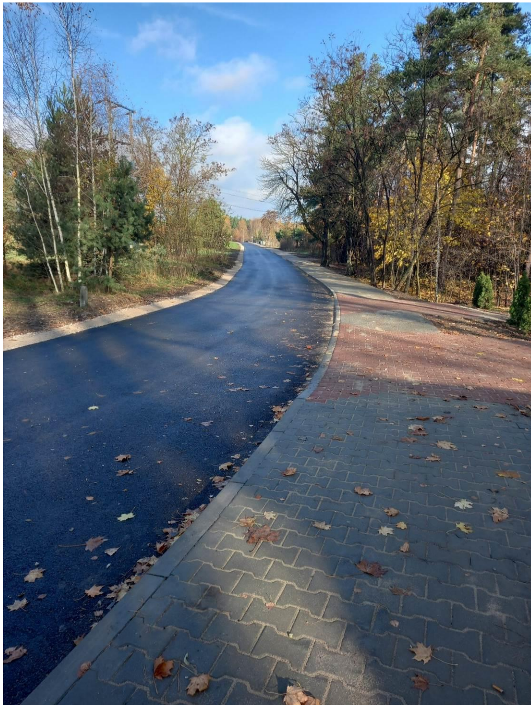
Zdjęcie 5.3.2. Przebudowa drogi wraz z budową chodnika w miejscowości Łączkowiec na dz. nr ewid. 171
