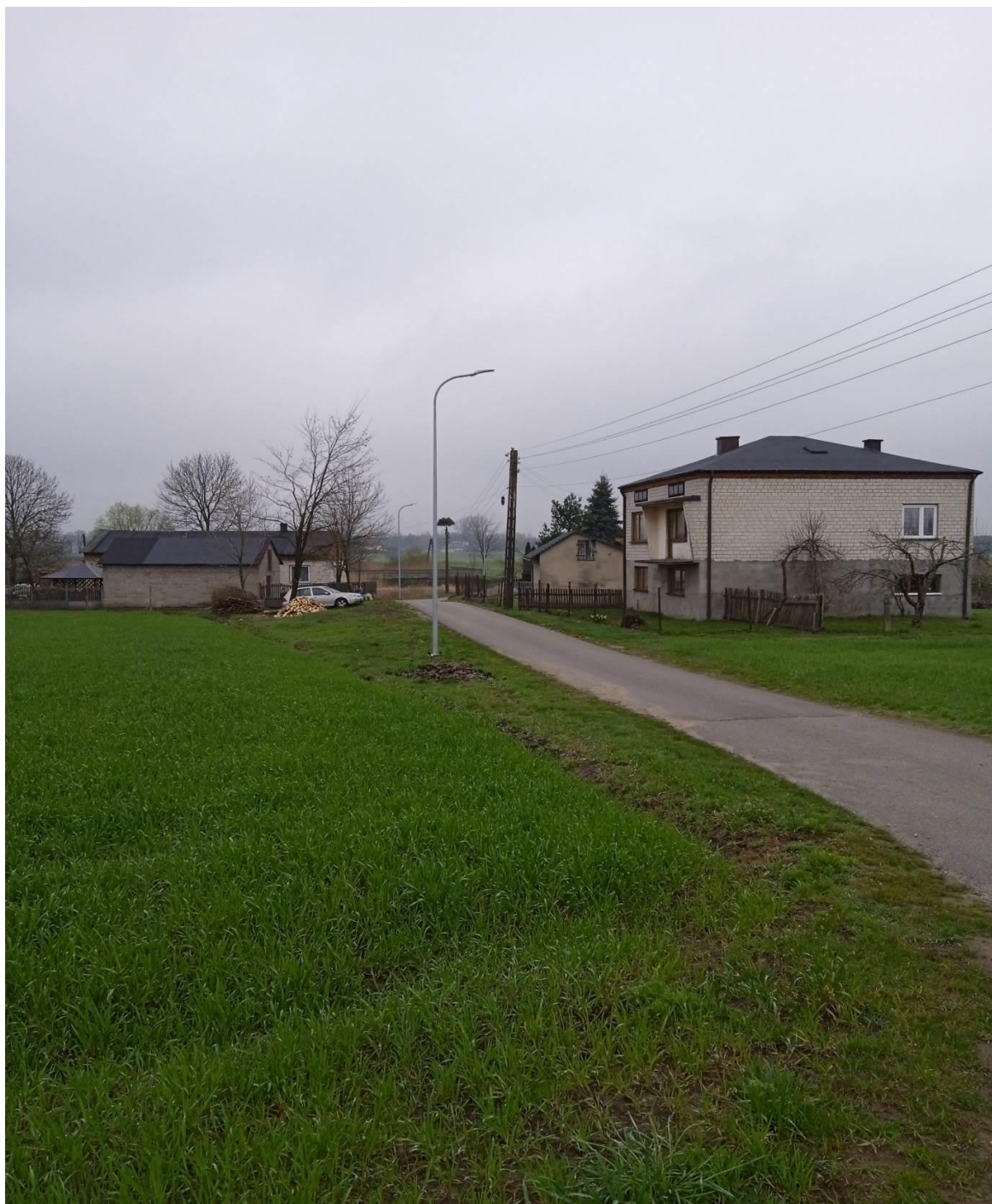
Zdjęcie 5.4.2. Rozbudowa oświetlenia ulicznego w miejscowości Przerąb na dz. o nr ewid. 650/1, 649, 648, 647, 646, 645, 644, 643, 637 ob. geod. Przerąb
