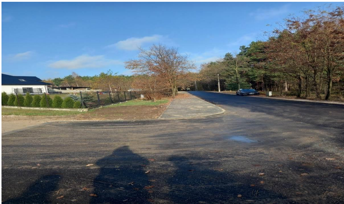
Zdjęcie 5.3.3. Przebudowa drogi wraz z budową chodnika w miejscowości Łączkowiec na dz. nr ewid. 171
