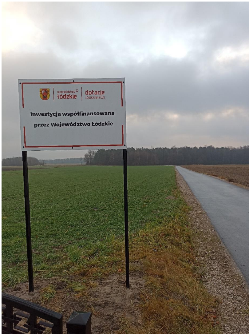
Zdjęcie 5.2.1. Przebudowa drogi dojazdowej do gruntów rolnych w miejscowości Huta Przerębska na działce o nr ewid. 30
