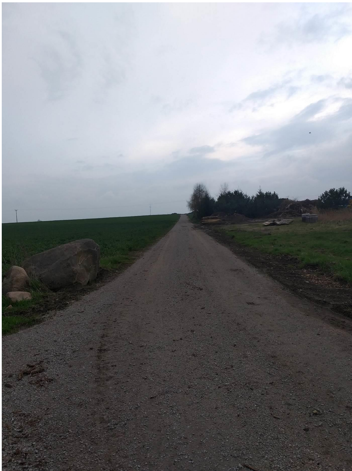
Zdjęcie 5.3.16. Przebudowa dróg wewnętrznych w miejscowości Kalinki na dz. o nr ewid. 220, 225, 270 obręb Kalinki
