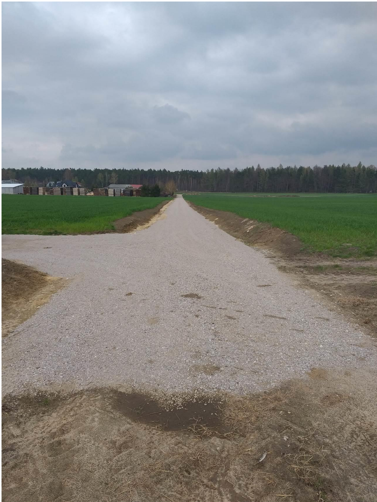
Zdjęcie 5.3.17. Przebudowa dróg wewnętrznych w miejscowości Kalinki na dz. o nr ewid. 220, 225, 270 obręb Kalinki
