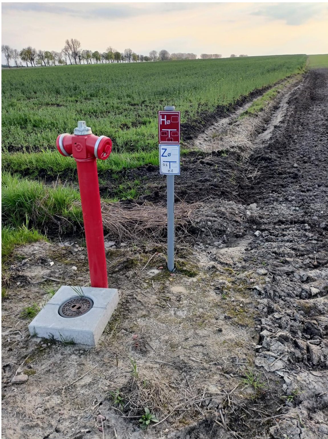
Zdjęcie 5.4.3. Budowa sieci wodociągowej w miejscowości Granice
