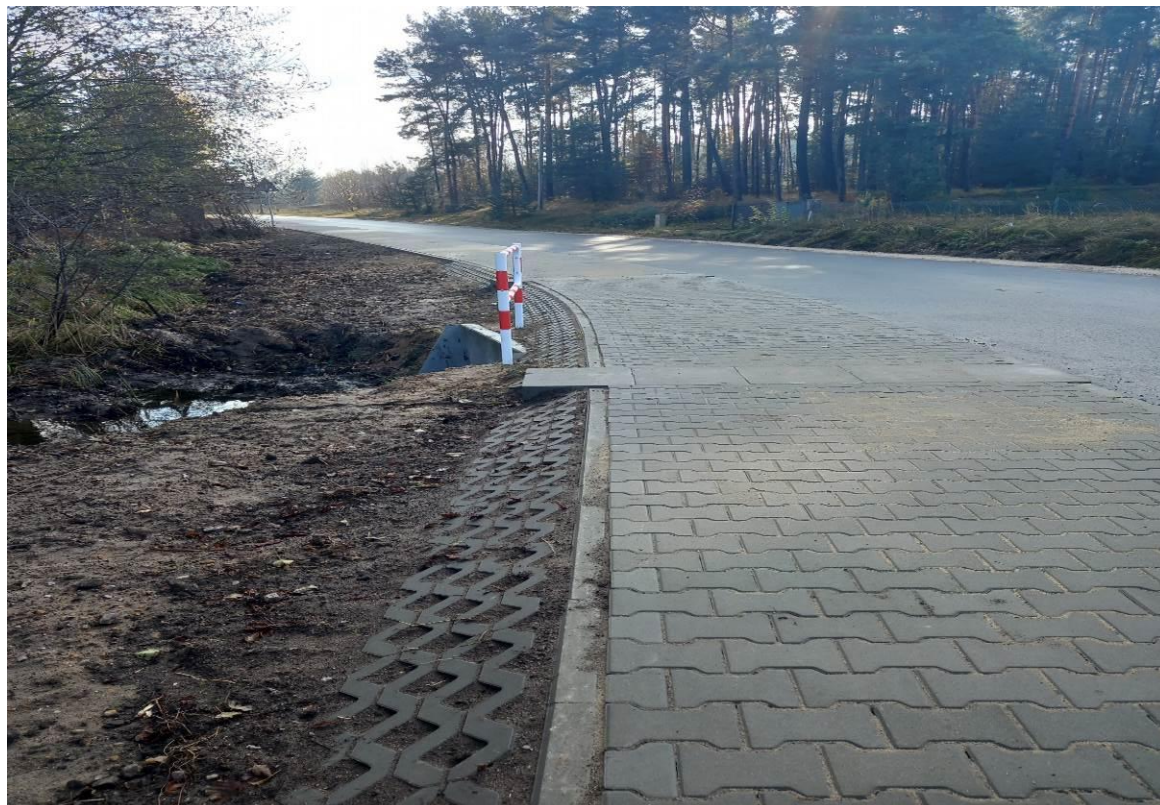
Zdjęcie 5.3.4. Przebudowa drogi wraz z budową chodnika w miejscowości Łączkowiec na dz. nr ewid. 171
