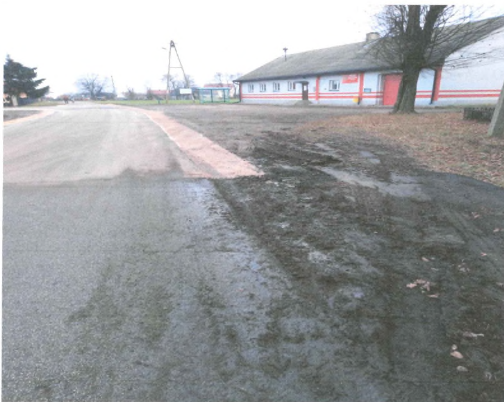
Zdjęcie Nr 2 po przebudowie dróg gminnych 17.12.2020 r. – w głębi widoczny nie utwardzony plac przy budynku OSP, pobocze nieutwardzone (błoto).
