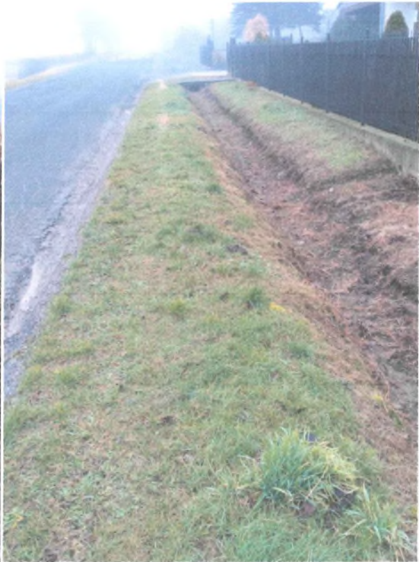
Zdjęcia 5 i 6 – Powierzchnia pasa drogowego do wykorzystania na chodnik, widoczne zarysy rowu przydrożnego do wyciszczenia na spływ wód opadowych.
