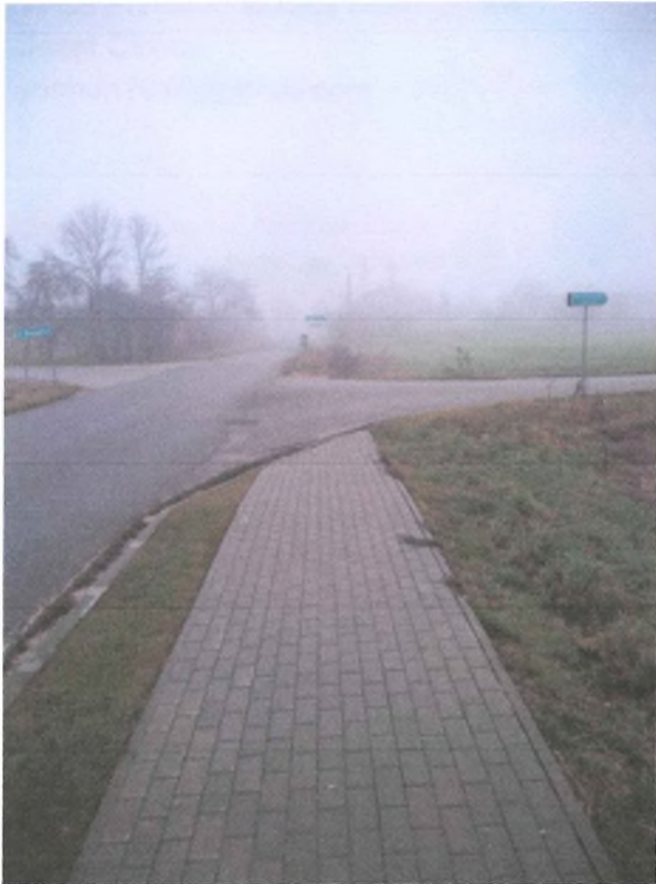
Zdjęcie 3 – Chodnik z kostki brukowej do skrzyżowania dróg powiatowych
