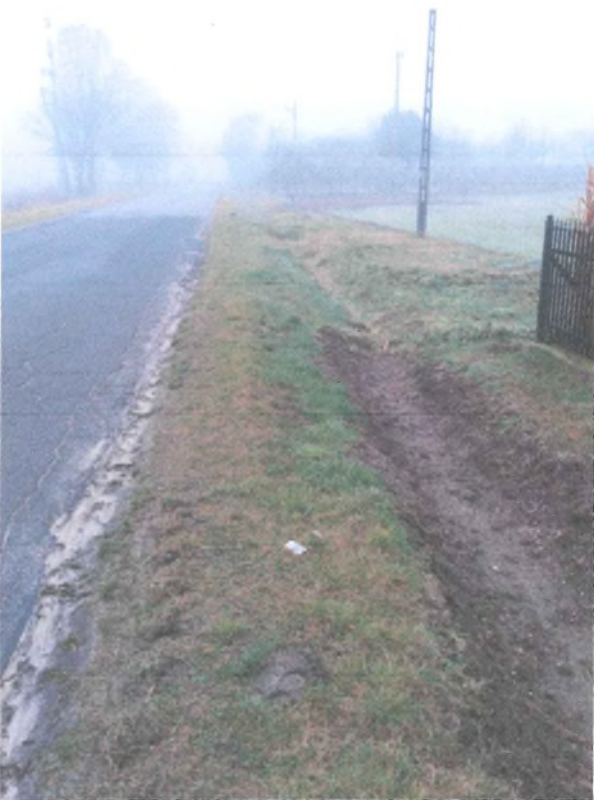
Zdjęcia 5 i 6 – Powierzchnia pasa drogowego do wykorzystania na chodnik, widoczne zarysy rowu przydrożnego do wyciszczenia na spływ wód opadowych.
