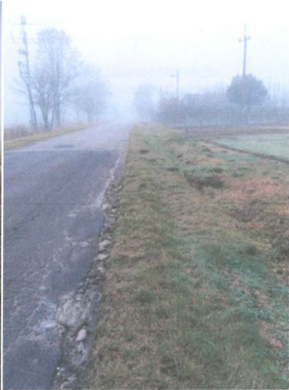
Zdjęcie 4 – Widok za skrzyżowaniem dróg
