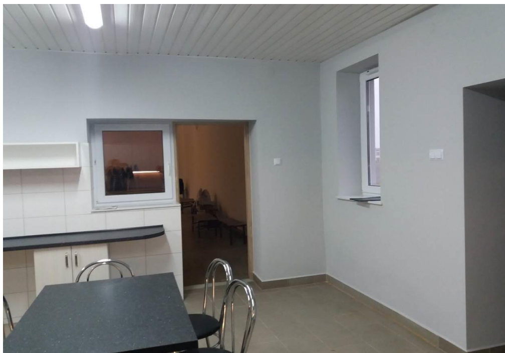
Zdjęcie 2.6.18. Przebudowa budynku OSP w Bartodziejach
