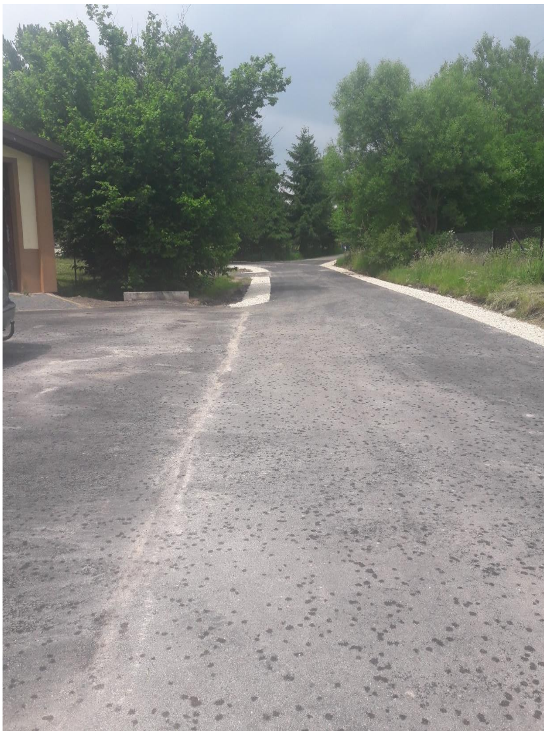
Zdjęcie 2.6.2. Przebudowa drogi w miejscowości Korytno
