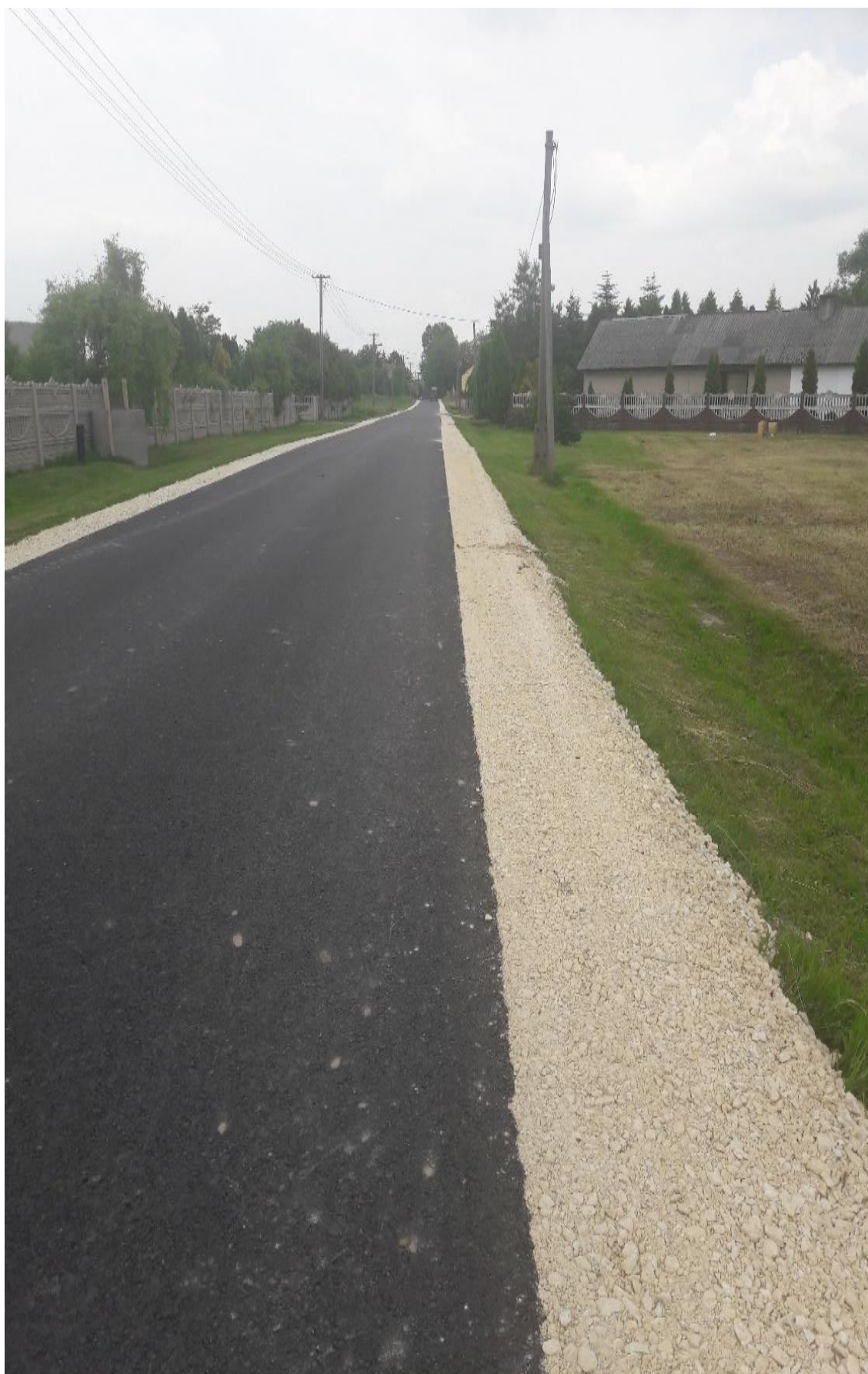
Zdjęcie 2.6.4. Przebudowa drogi w miejscowości Koconia (wieś)
