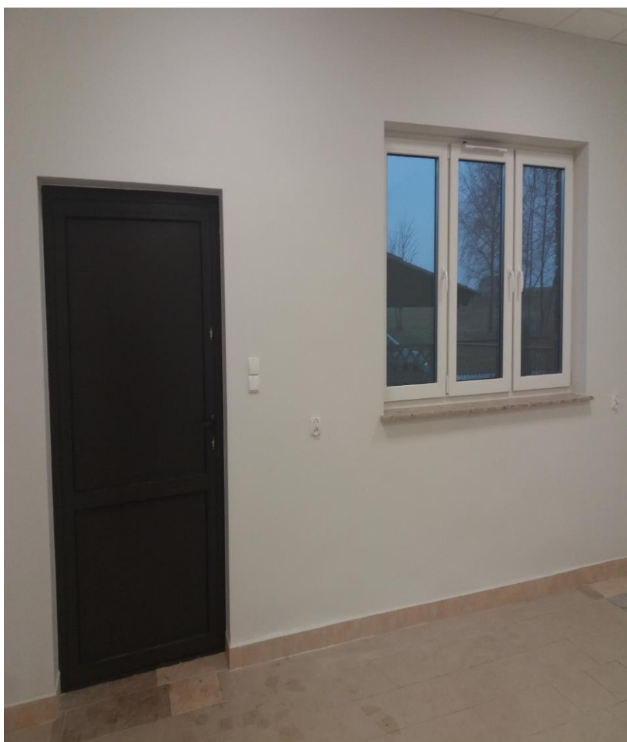
Zdjęcie 2.6.12. Przebudowa budynku OSP w Kalinkach
