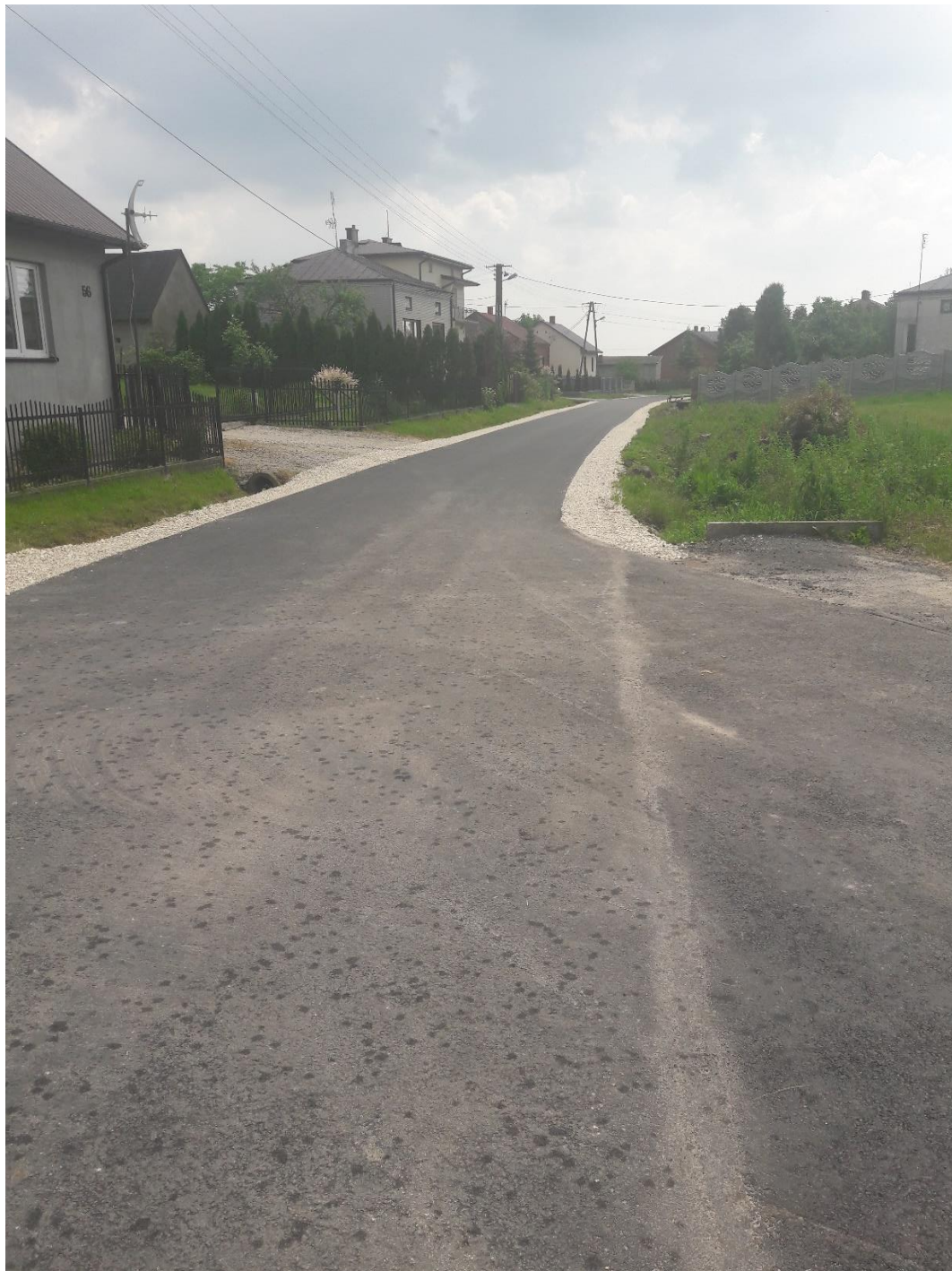
Zdjęcie 2.6.1 Przebudowa drogi w miejscowości Korytno
