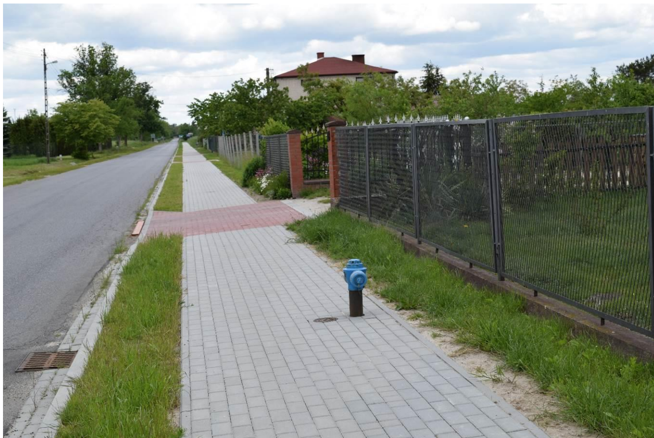
Zdjęcie 2.6.9. Budowa chodnika przy drodze powiatowej w Przerębie
