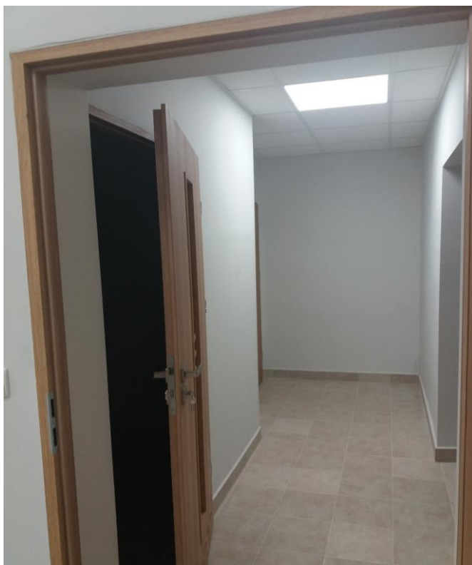
Zdjęcie 2.6.14. Przebudowa budynku OSP w Kalinkach
