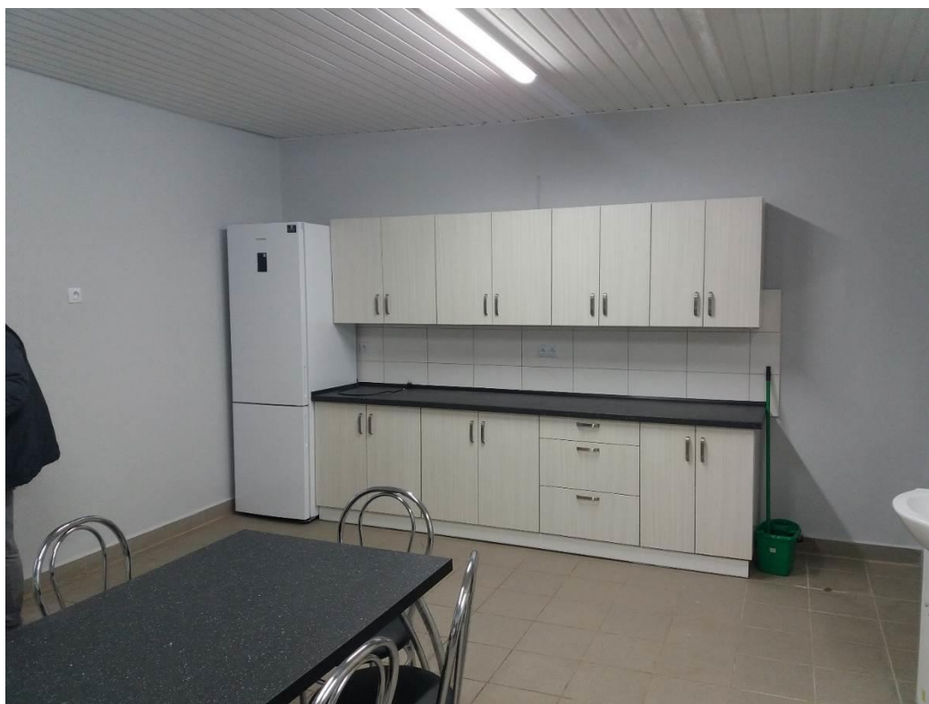
Zdjęcie 2.6.17. Przebudowa budynku OSP w Bartodziejach
