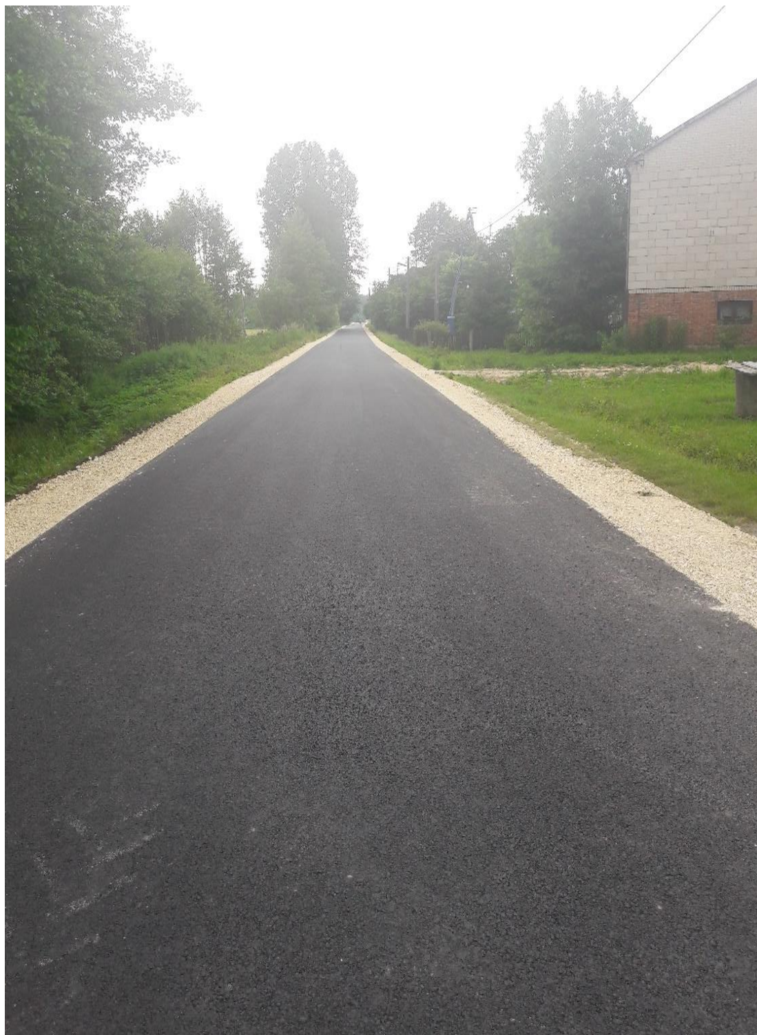
Zdjęcie 2.6.3. Przebudowa drogi w miejscowości Koconia (wieś)
