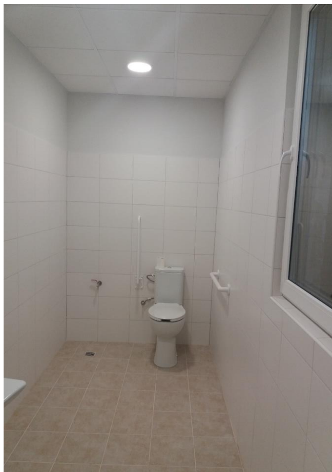
Zdjęcie 2.6.15. Przebudowa budynku OSP w Kalinkach
