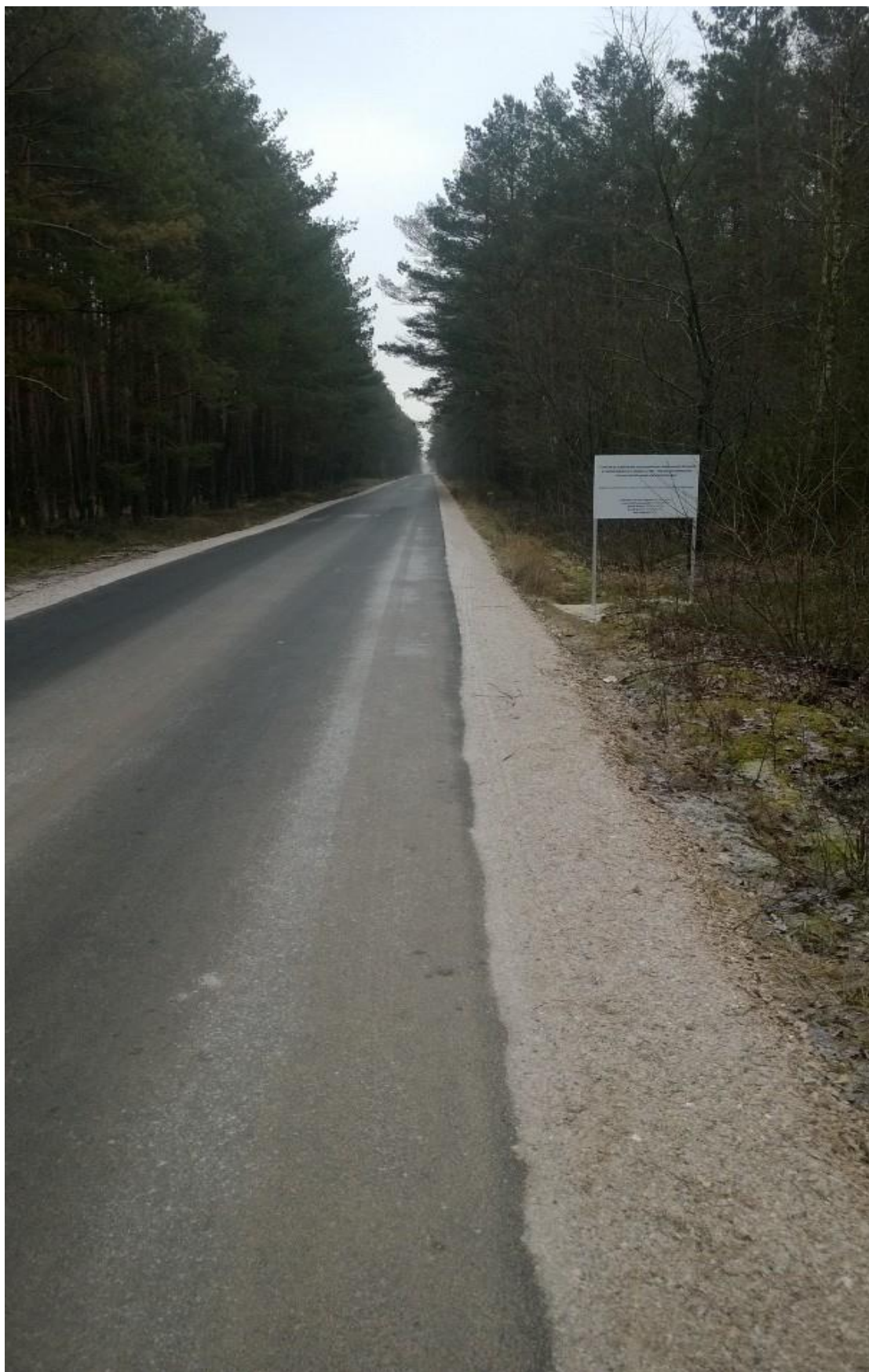
Zdjęcie 2.6.8. Trzeci etap przebudowy drogi gminnej w miejscowości Ochotnik
