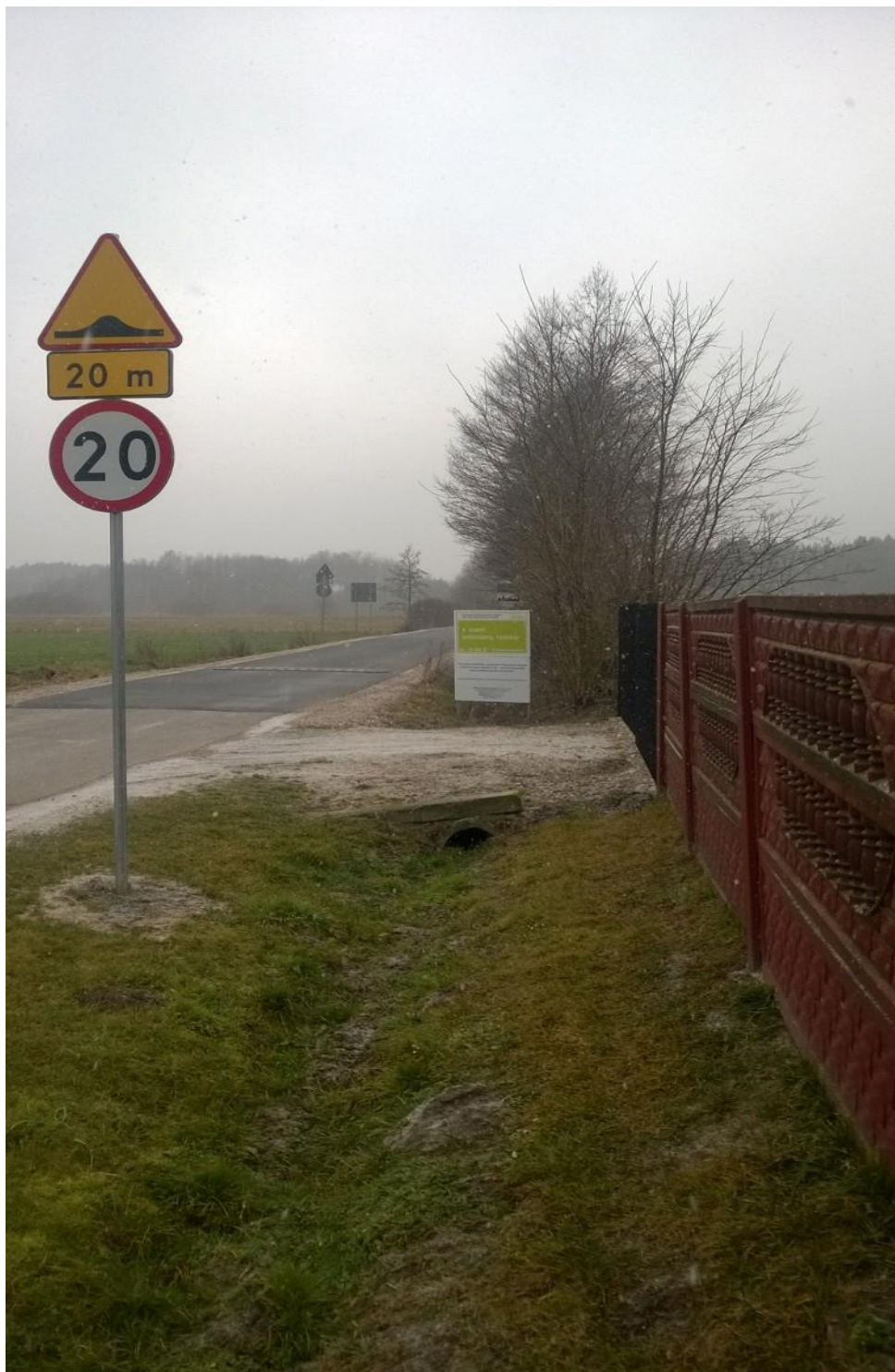
Zdjęcie 2.6.7. Trzeci etap przebudowy drogi gminnej w miejscowości Ochotnik
