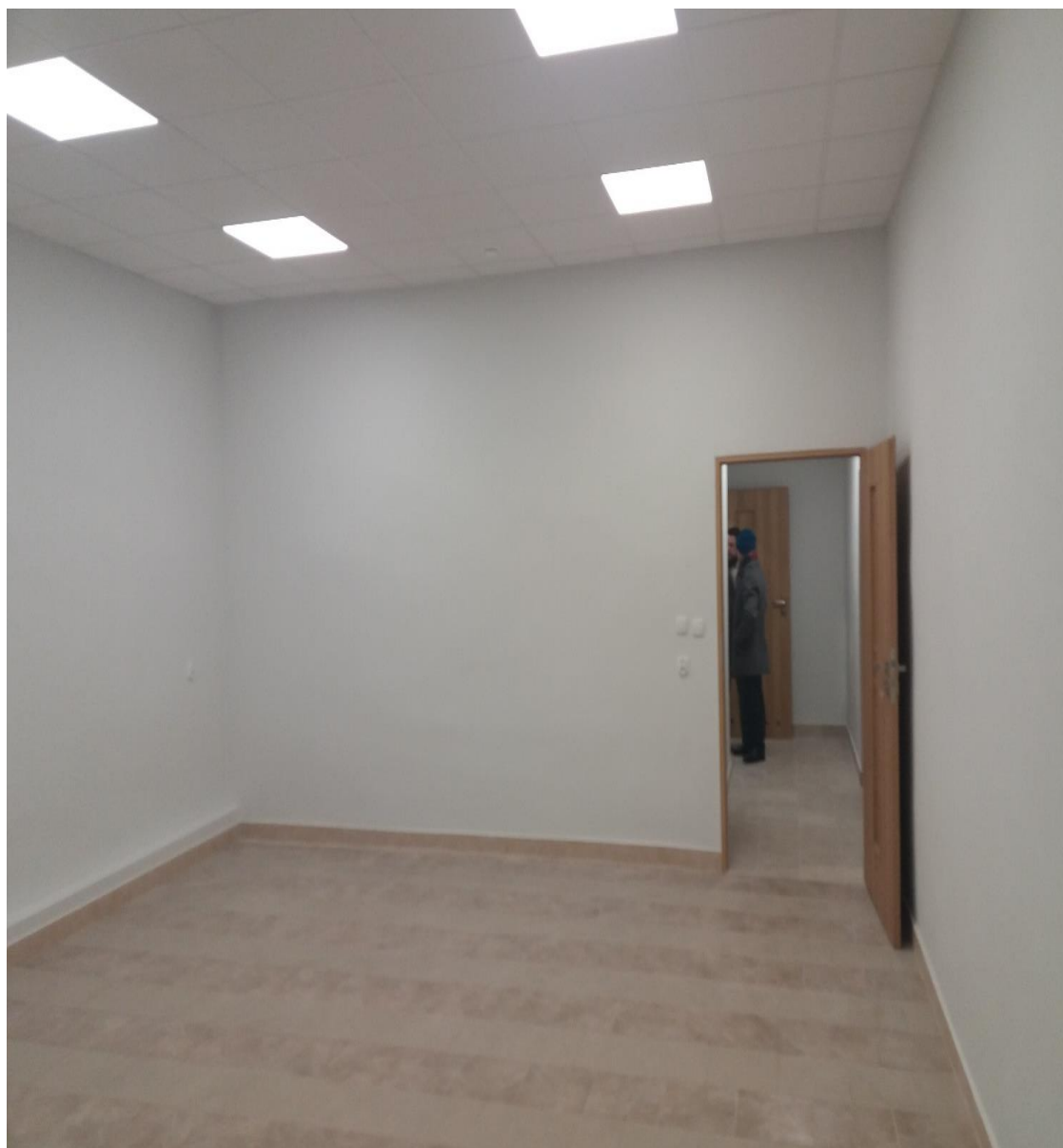
Zdjęcie 2.6.13. Przebudowa budynku OSP w Kalinkach
