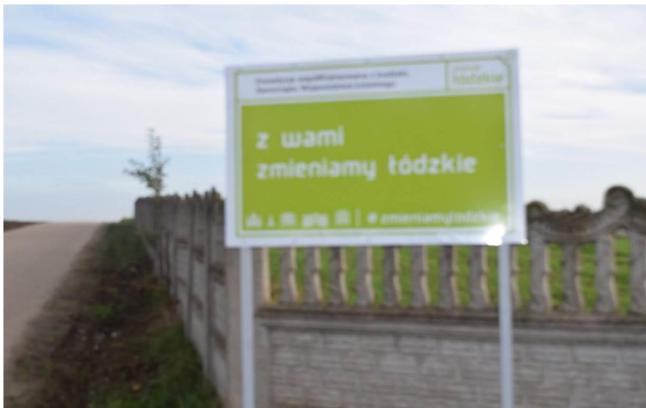
Zdjęcie 2.6.5 – 2.6.6. Przebudowa drogi dojazdowej do gruntów rolnych w miejscowości Chełmo
