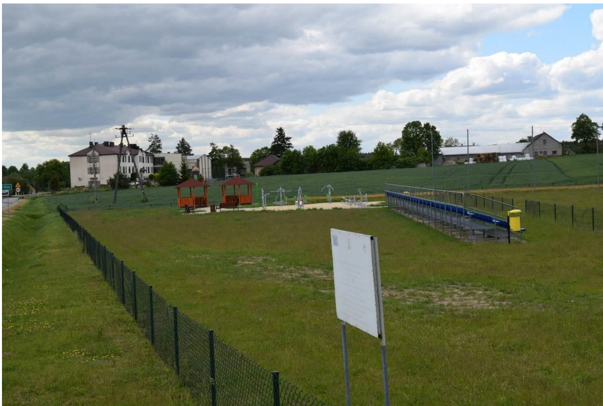
Zdjęcie 2.6.20. Budowa siłowni zewnętrznej w miejscowości Masłowice
