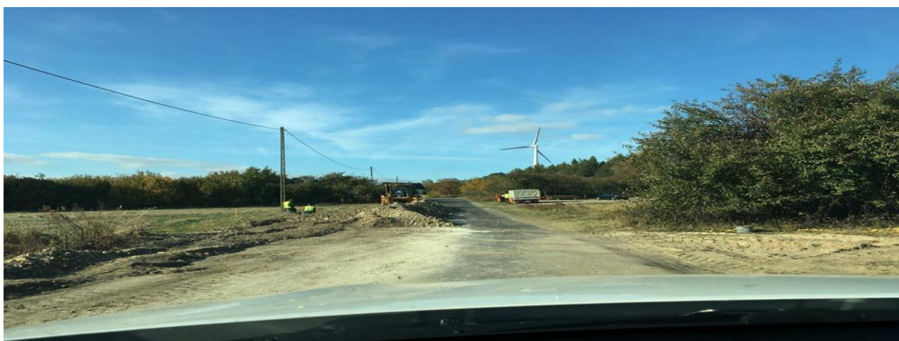
Budowa odcinka wodociągu w miejscowości Korytno trakcie robót
